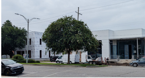
Allen Toussaint Blvd construction
